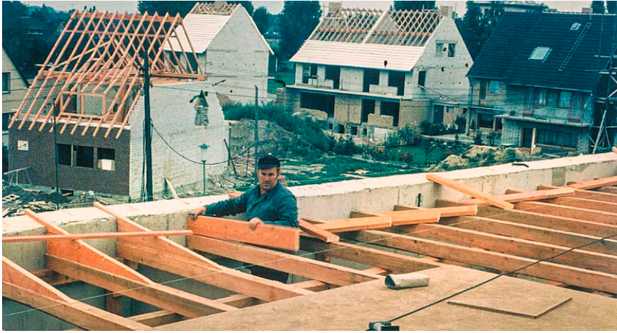
Der Holzbüttger Zimmermeister Herbert Bolten
