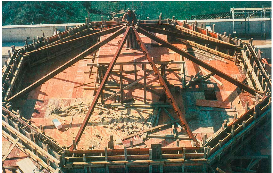
Der Dachstuhl von Sieben-Schmerzen.Mariens im Rohbau
